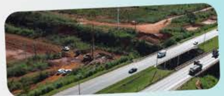
Construção de 2 pontes Parque Rio Branco - Jardim Ipanema Parque Esplanada 6 - Parque Marajó
